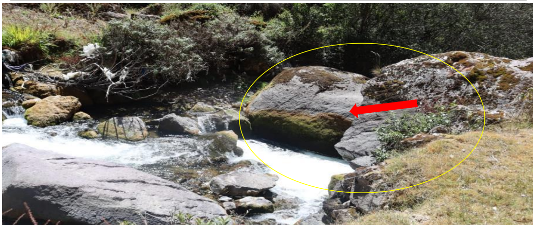
FIGURA N°03: SE OBSERVA QUE EL CAUCE CENTRAL DEL RIO ESTA COLMATADO CON PIEDRAS GRANDES LO CUAL ES UN PROBLEMA PARA EL FLUJO NORMAL DEL RIO EN MAXIMAS AVENIDAS, SE REQUIERE LIMPIAR ESAS ROCAS GRANDES Y/O HACER VOLADURA.
