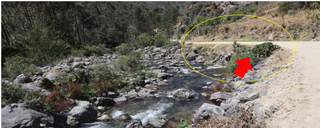
FIGURA N°02: SE OBSERVA SEGUN LA FOTO QUE SOLO LA DEFENSA NATURAL QUE PROTEGE A LA ACCRETERA SON SOLO ROCAS AMONTONADAS NO HAY NINGUNA PROTECCION TECNICA ESTRUCTURAL.
