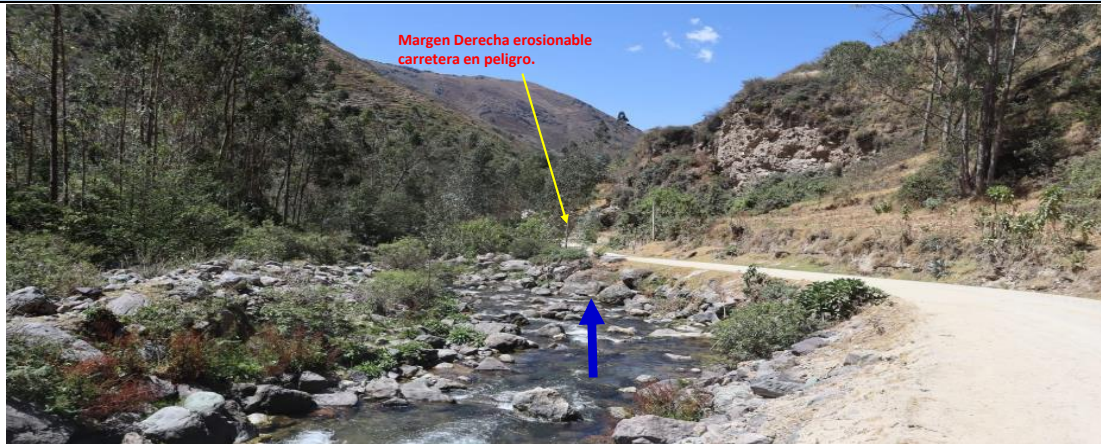
FIGURA N°01: TRAMO CRÍTICO EN EL RÍO ULCUMAYO (RIO MACHO), EN EL SECTOR DE MOSHOCSHACA SE OBSERVA COMO SE ENCUENTRA LA VIA, LA CARRETERA EN PELIGRO DE PERDIDA SI EL RIO MACHO INCREMENTA SU CAUDAL POR EFECTOS DE LLUVIAS EN EL PRESENTE AÑO.
